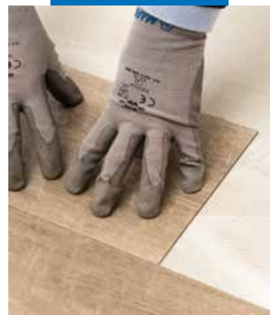
Aplicação de LVT com Ultrabond Eco V4 Evolution
