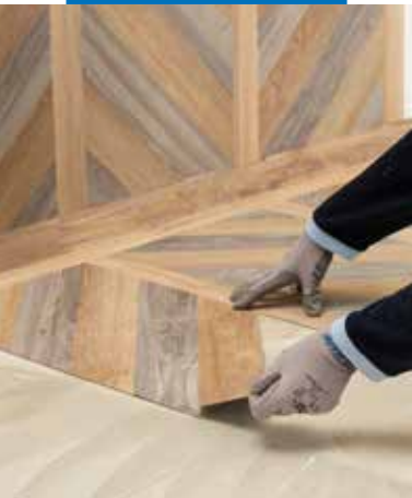
Aplicação de LVT modular com Ultrabond Eco V4 Evolution
