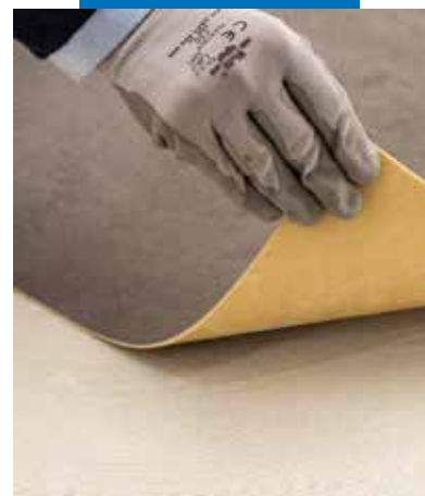
Aplicação de pavimento de base poliuretânica com Ultrabond Eco V4 Evolution
