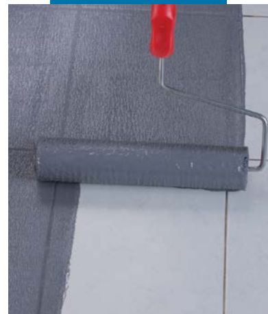
Aplicação a rolo de Eco Prim Grip sobre uma pavimentação em ladrilhos de grés porcelânico pré existente
