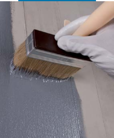
Aplicação a pincel do Eco Prim Grip sobre suporte em betão
