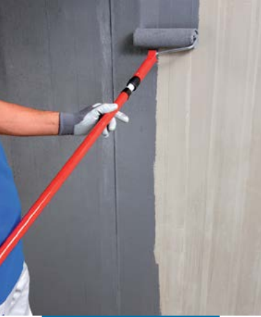
Aplicação a rolo do Eco Prim Grip sobre suporte em betão
