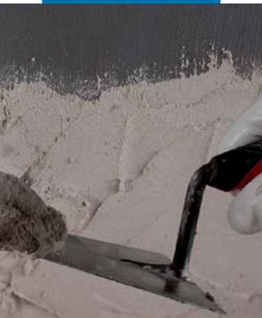
Aplicação do reboco sobre o Eco Prim Grip
