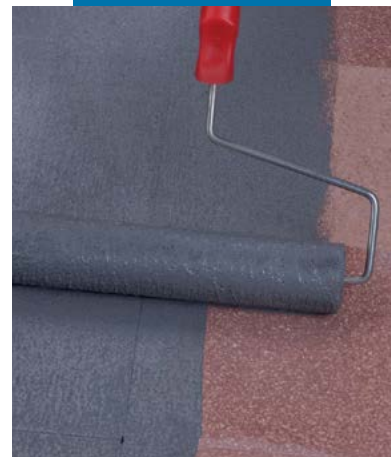
Aplicação de a rolo Eco Prim Grip sobre uma velha pavimentação em mármore
