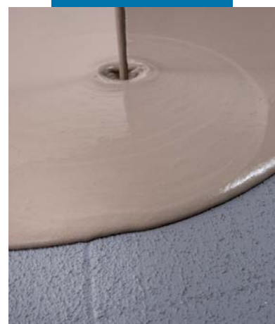
Aplicação da argamassa de regularização autonivelante Ultraplân sobre o Eco Prim Grip seco e aplicado sobre um velho pavimento
