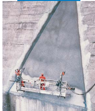
Exemplo de aplicação por projeção de Mapelastic numa barragem
