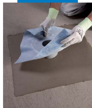
Aplicação de Drain Vertical, ralo de descarga sobre Mapelastic
