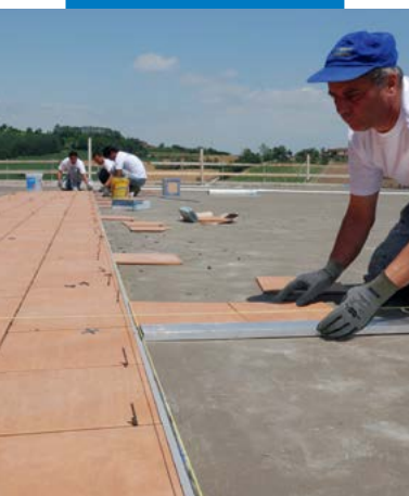
Assentamento de cerâmica com Kerabond + Isolastic
