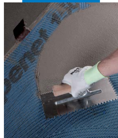
Aplicação de Mapelastic sobre Mapenet 150
