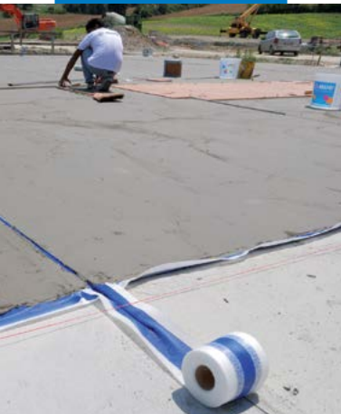
Impermeabilização de betonilhas com Mapelastic e Mapeband
