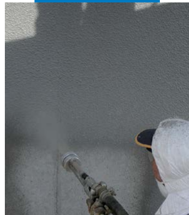
Exemplo de aplicação por projeção de Mapelastic num viaduto
