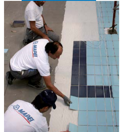
Assentamento de revestimento cerâmico sobre Mapelastic
