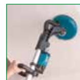
Ponçage des murs
