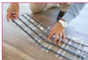
Positionner les plaques et les clipser entre elles.
