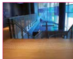
Pose sur parquet
