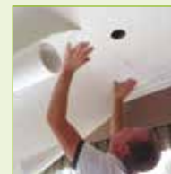
2- Positionner le début de la laize sur le trait
