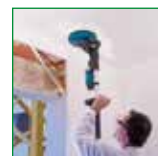
Ponçage des plafonds
