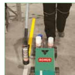
Traçage le long des palettes, murs, grâce au bras déporté
