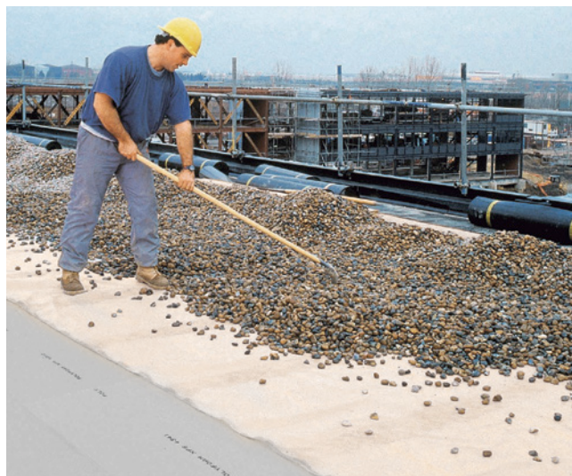
Figura 6. Rehabilitación de cubierta plana con Polyfoam.
